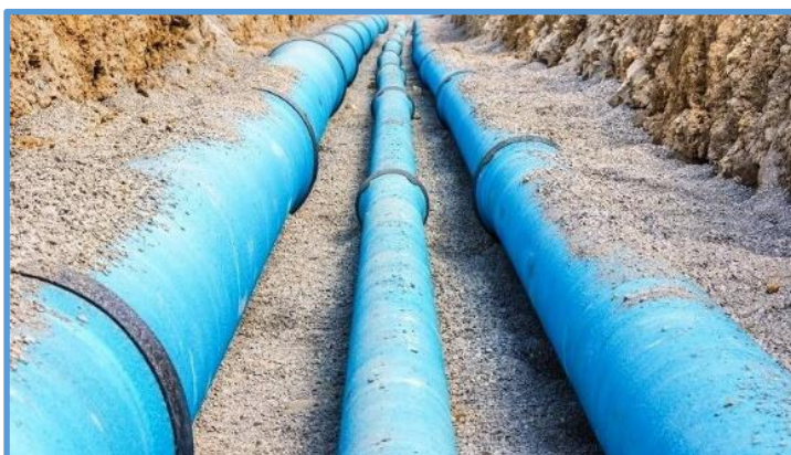
W CIĄGU ROKU 2021 ODDALIŚMY DO UŻYTKU 42 KM SIECI WODOCIĄGOWEJ s. 12
