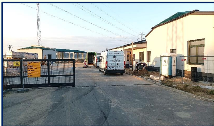
RAPORT Z BUDOWY PSZOK, s. 9
